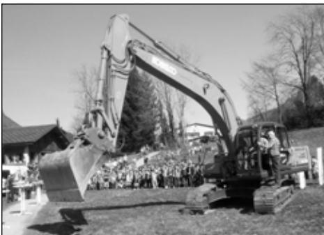
Der Spatenstich Ende März 2012
