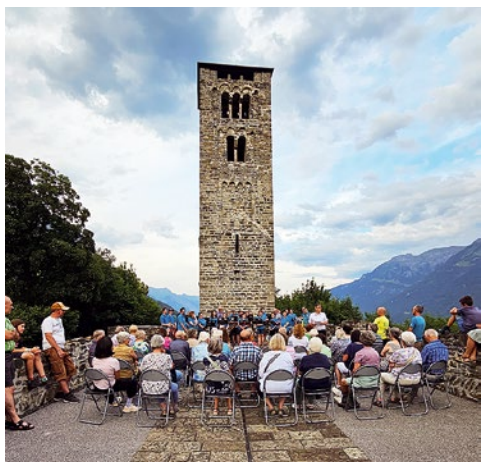
Der «Campanile», der Glockenturm aus dem 11. Jahrhundert, ist Teil der Kirchenruine St. Peter
